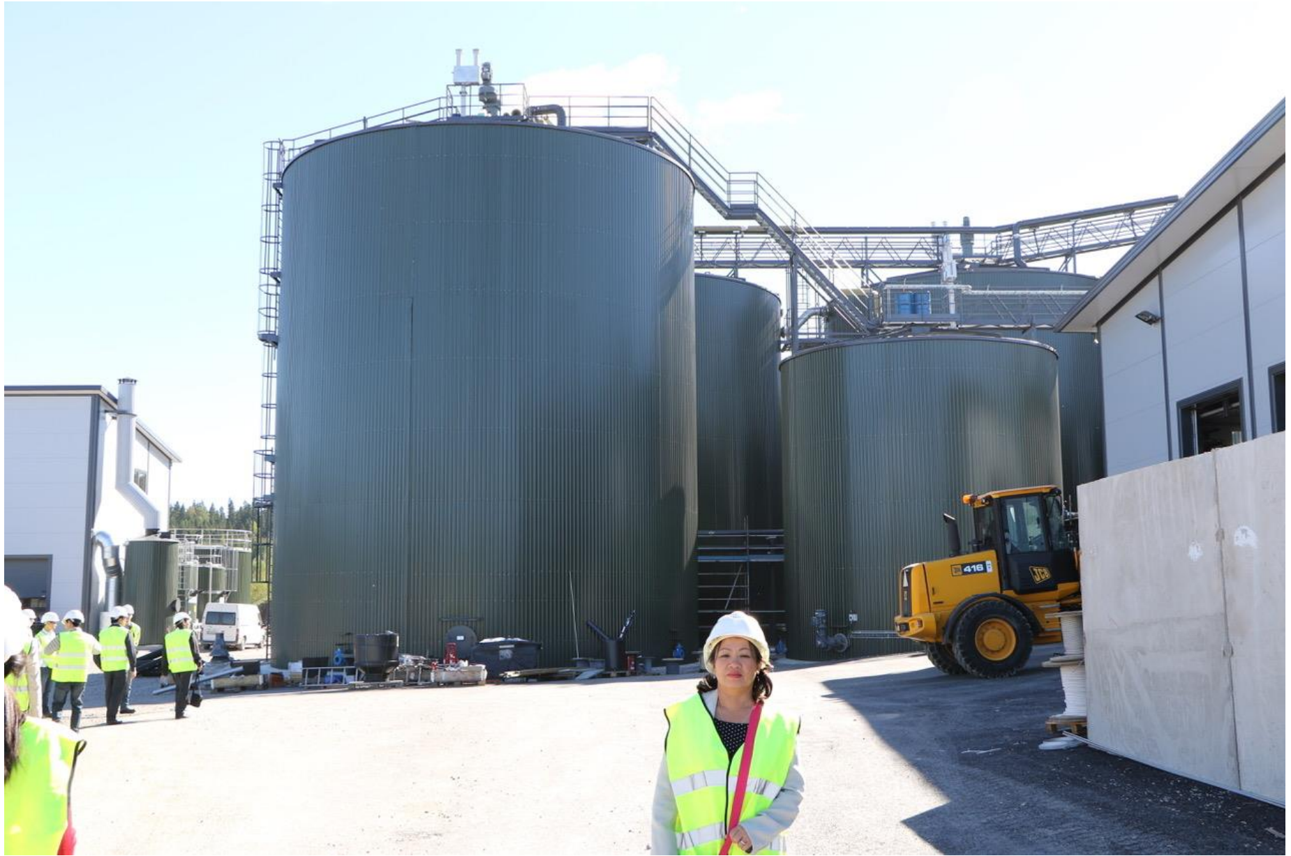
Si lô chứa rác, Cv = 6000 m 3 Solid waste Storage Silos, Cv = 6000 m 3
