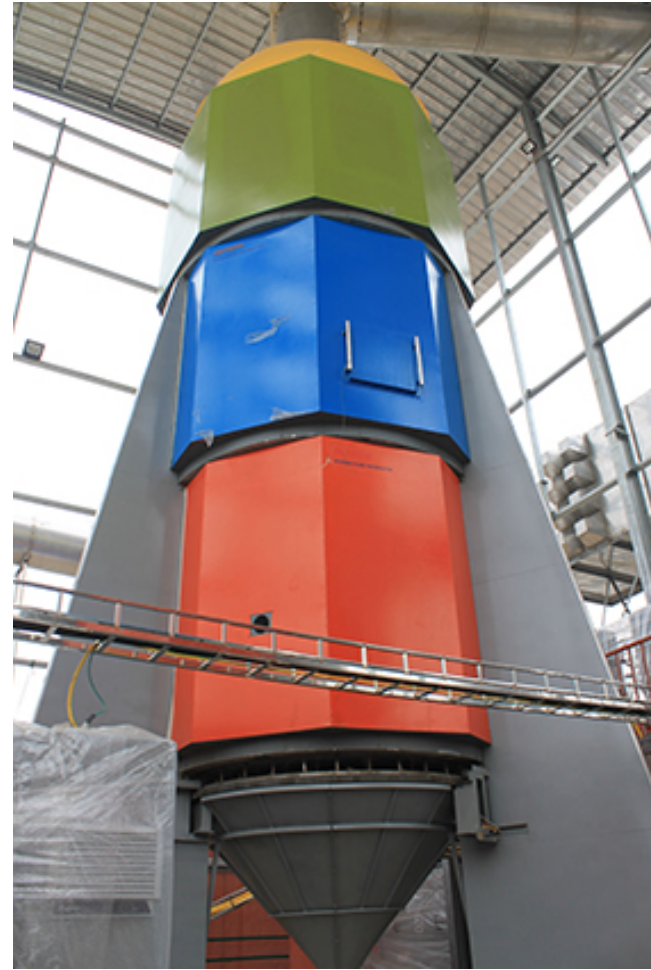
Lò plasma IP- 250 (Đã được lắp đặt tại NMR Đông Anh)
