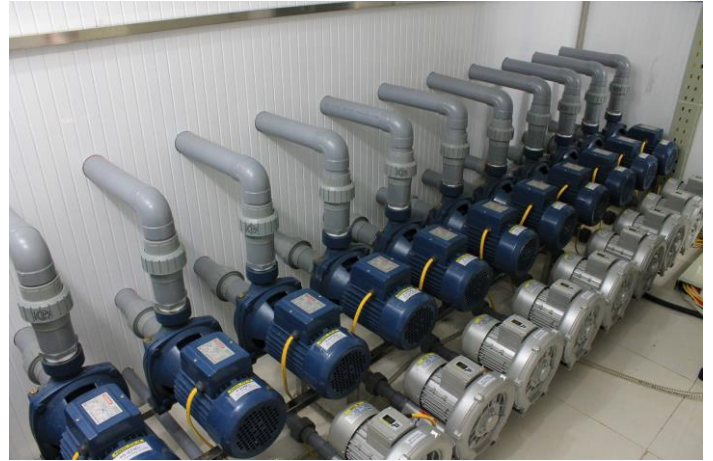
MÁY CẤP KHÍ TƯƠI VÀ BƠM CHUYỂN NƯỚC (Cấu hình công suất lớn - giá thành hạ)
