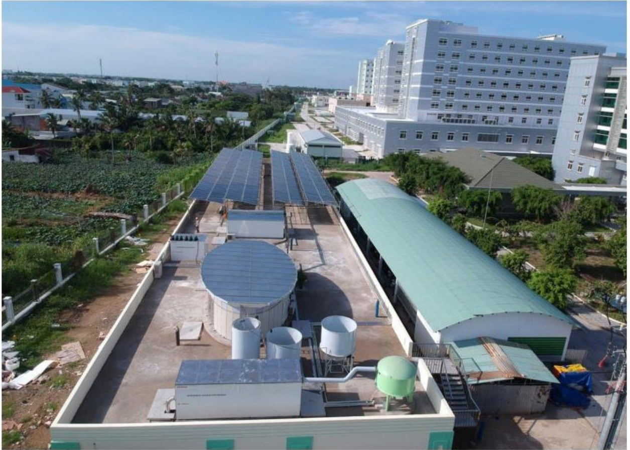
Toàn cảnh hệ thống xử lý nước thải sử dụng năng lượng mặt trời tại Bệnh viện Đa Khoa Kiên Giang (2019).
