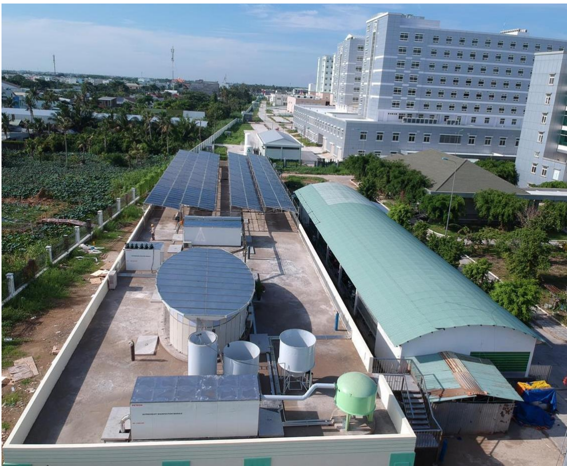
Hình 4: Toàn cảnh Hệ thống xử lý nước thải Bệnh viện Đa khoa Kiên Giang, 2400 m 3 /ngày.
