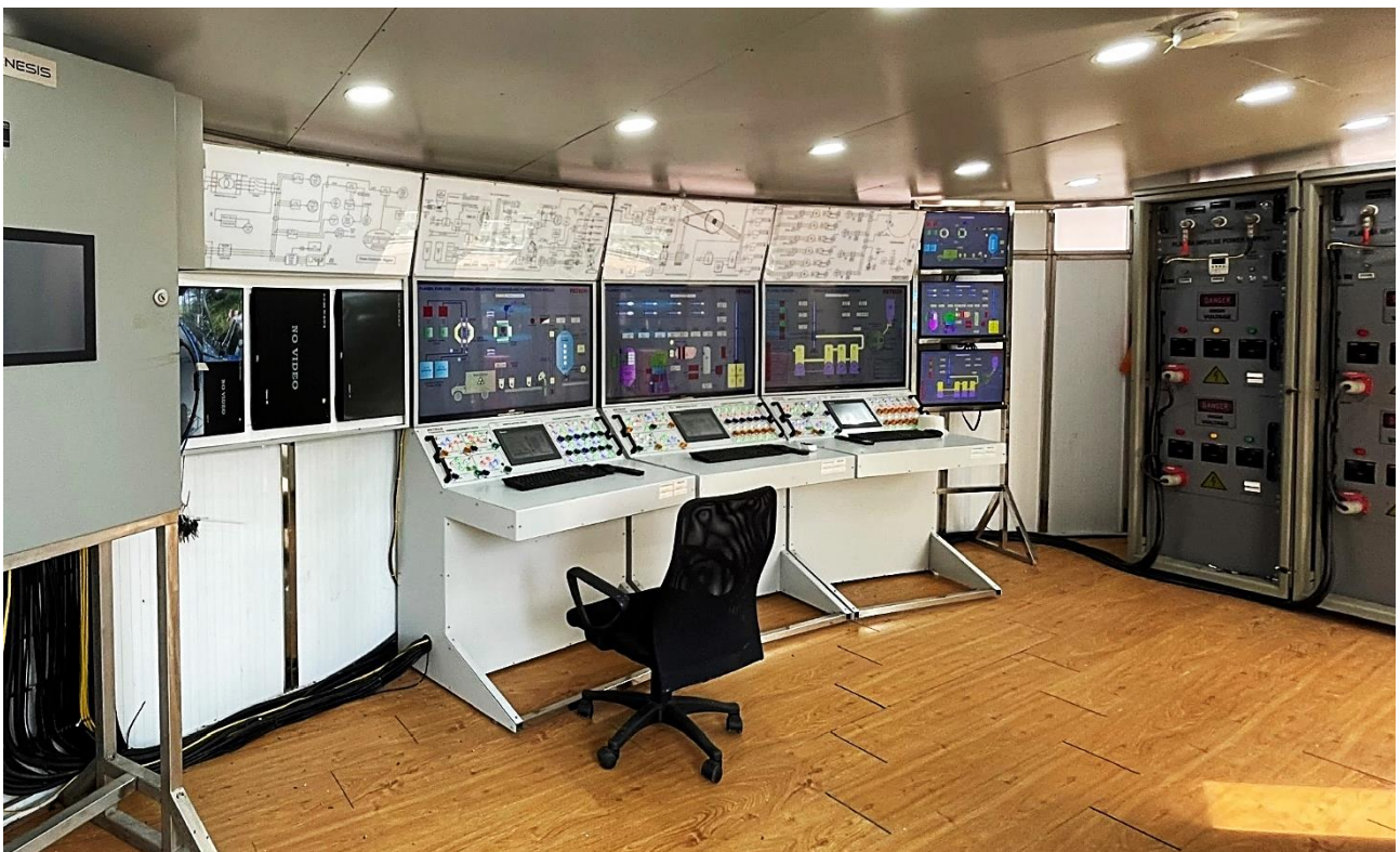
Hình 2: Phòng Điều hành RmS (KG2020), sử dụng cho các HT XLNT công suất lớn.
