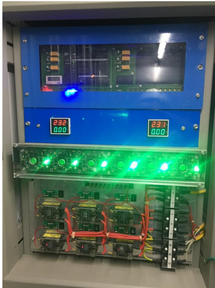
Hình 1: Thiết bị RmS – 9u, sử dụng cho các HT XLNT công suất nhỏ.
